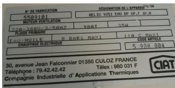
Photos 10 : plaques de 2 des 4 aérothermes
