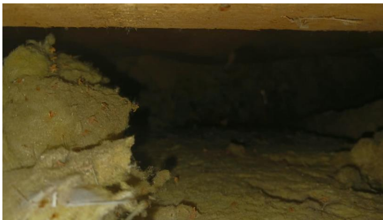
Photo 14 : intérieur du mur
