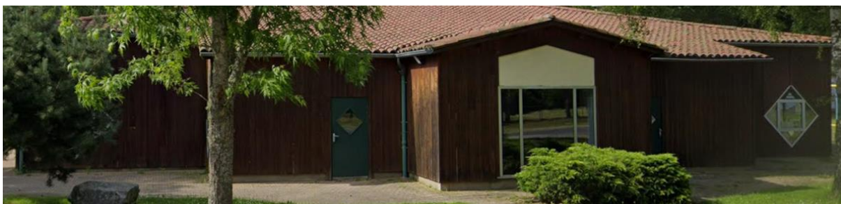
Photo 3 : face avant Sud
