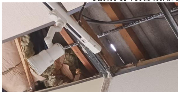
Photos 15 : sous toit avec ou sans laine de verre
