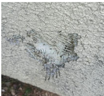
Photo 13 : doublage extérieur mur nord
