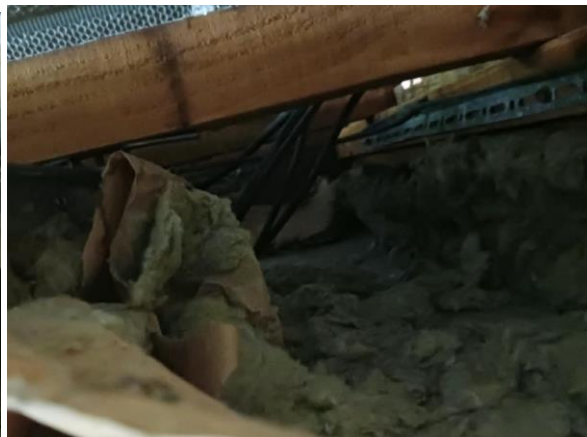
Photos 15 : sous toit avec ou sans laine de verre
